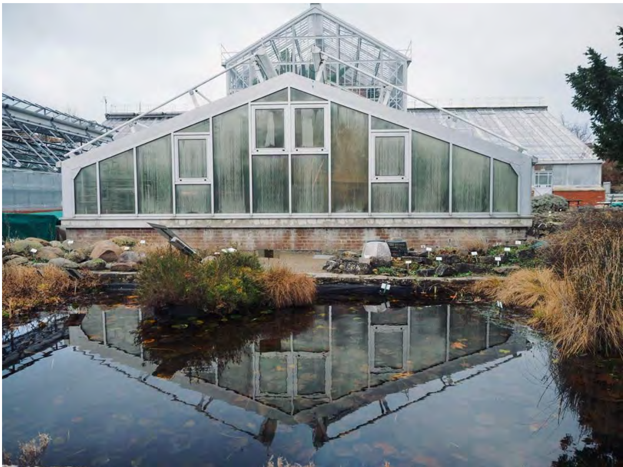
Gewächshausanlage Greifswald, Foto: Geert-Christoph Seidlein
