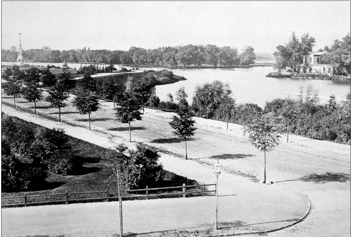
Knieperwall mit Hospitaler Bastion, Fotografie 1889
