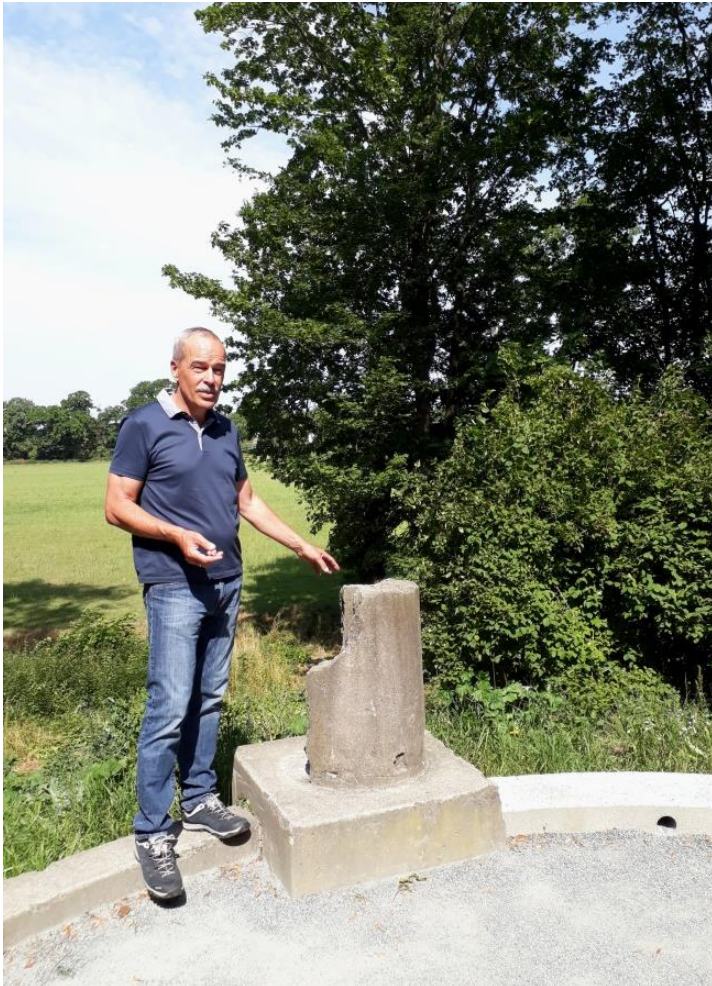
Gernot Hübner erläutert die Wiederherstellungsarbeiten am Apollo-Tempel, Foto: Angela Pfennig
